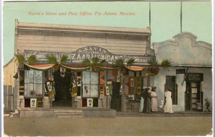
Exterior e Interior de Tienda de Curiosidades ca. 1906-1910
