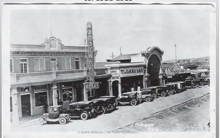
Interior y Exterior de Cantina ca. 1921-1925
