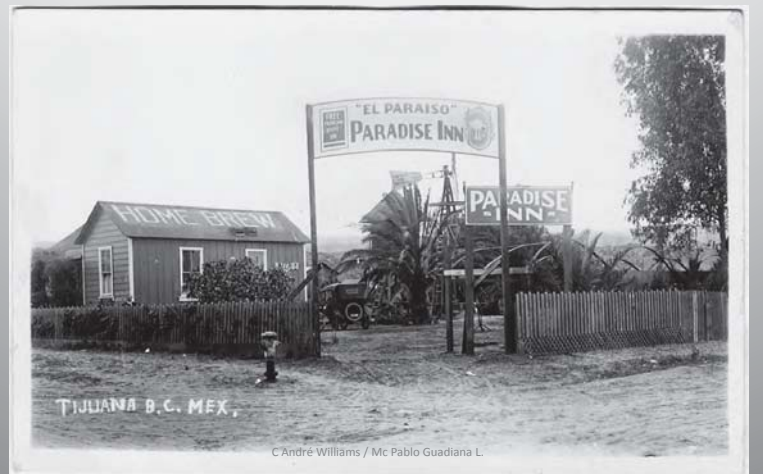
Interior y Exterior de Cantina ca. 1911-1915
