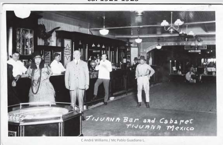
Interior y Exterior de Cantina ca. 1921-1925
